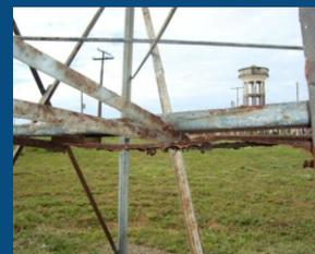
Estrutura metálica com corrosão
