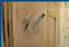
Eletródutos vandalizados pelos presos, com fiação exposta/retirada.
